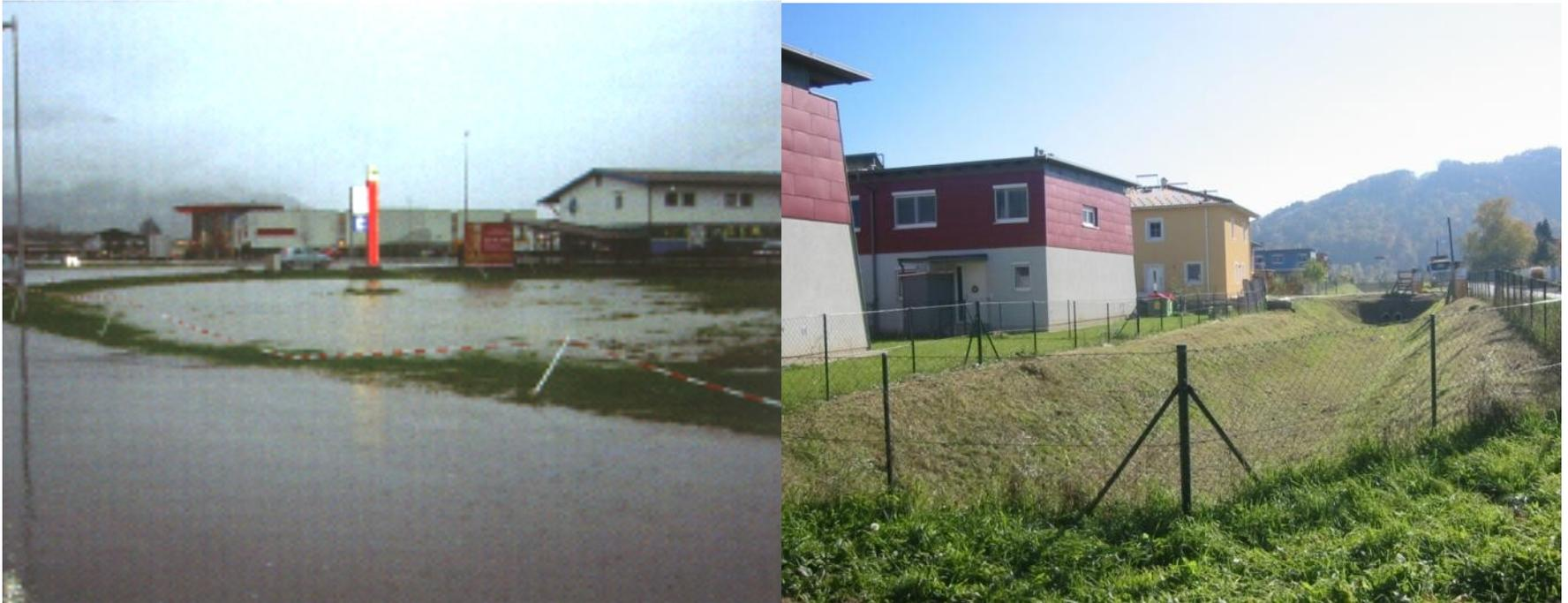
*Starkregenereignisse können sowohl in Sickerschächten als auch bei oberflächigen Versickerungsanlagen eine Überlastung bewirken, was einen oberflächigen Abfluss zu Folge hat. Dies kann ebenso durch eine Abnahme der Sickerfähigkeit durch Verschlämmung der Anlagen oder bei gefrorenem Bodenfilter ausgelöst werden.*
