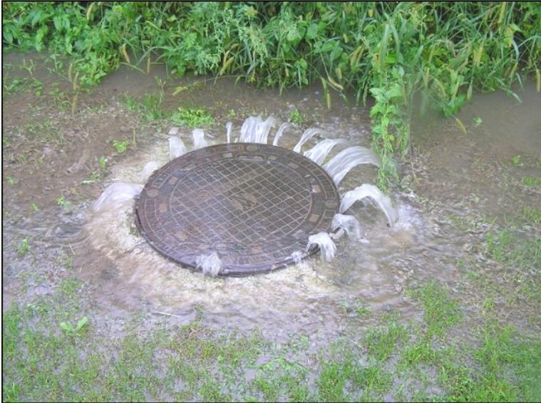
*Durch Verstopfung und/oder Überlastung der Kanalisation kann es zu einem Austritt der Wässer über Schächte auf öffentliche Bereiche kommen, wobei der dann oberflächige Abfluss zu einem Schaden an Bauwerken führen kann. Es kann aber auch bei einem Fehlen oder einer unsachgemäßen Rückstausicherung in der Hauskanalisation zu einem Rückstau in die Häuser selbst und zu einer Überflutung kommen.*
